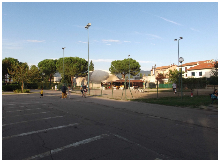
impianto di illuminazione esterno
