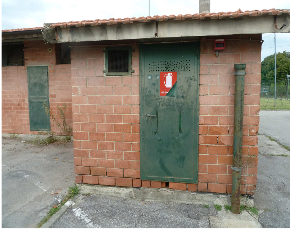
edificio locale centrale termica
