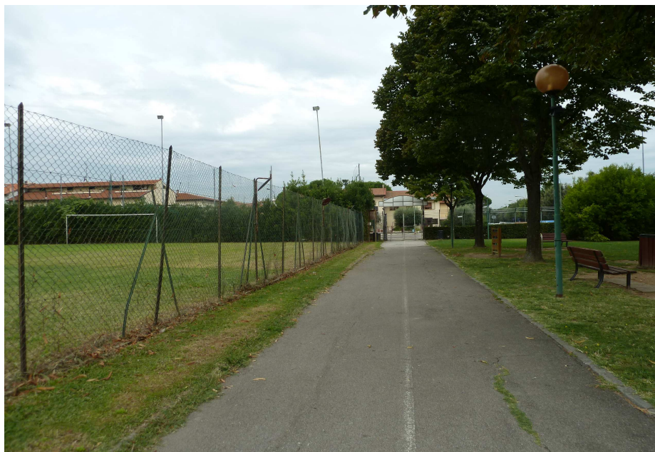
pavimentazione in tappeto d'usura in conglomerato bituminoso
