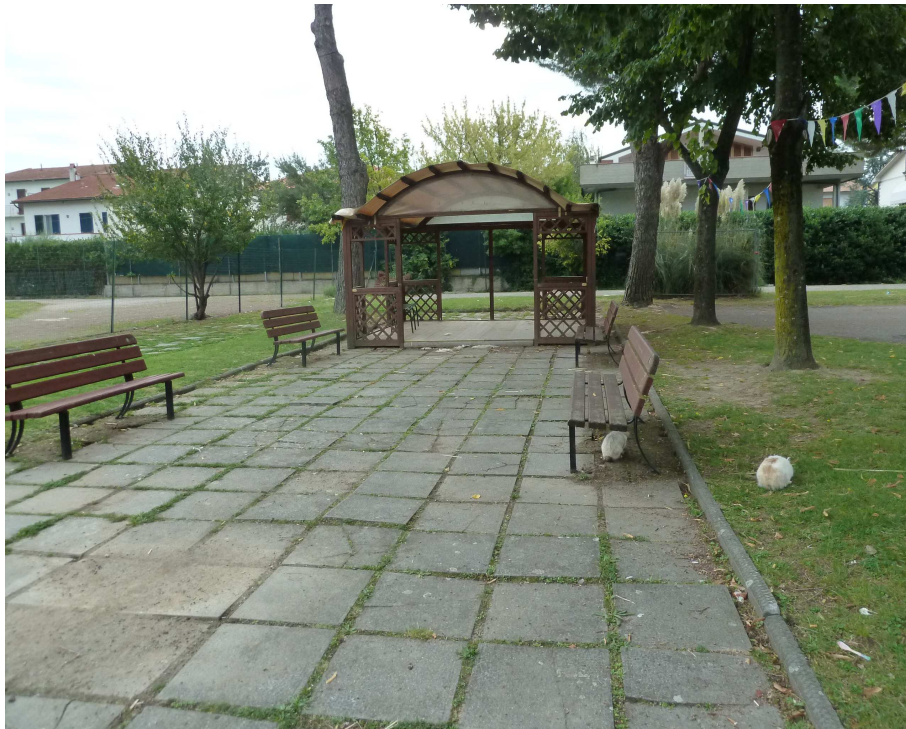
pavimentazione con lastre quadrate in cls prefabbricate
