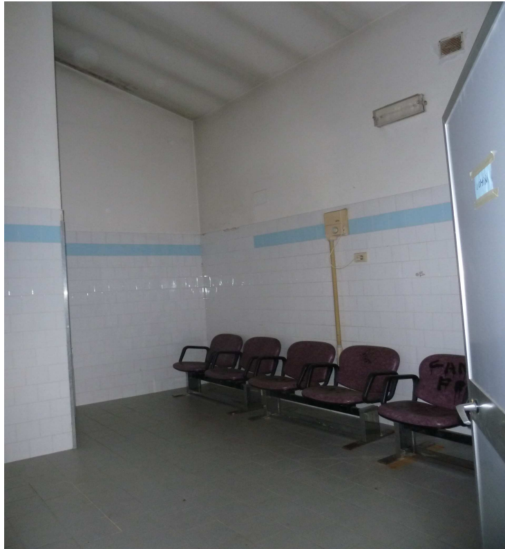
interni edificio servizi igienici
