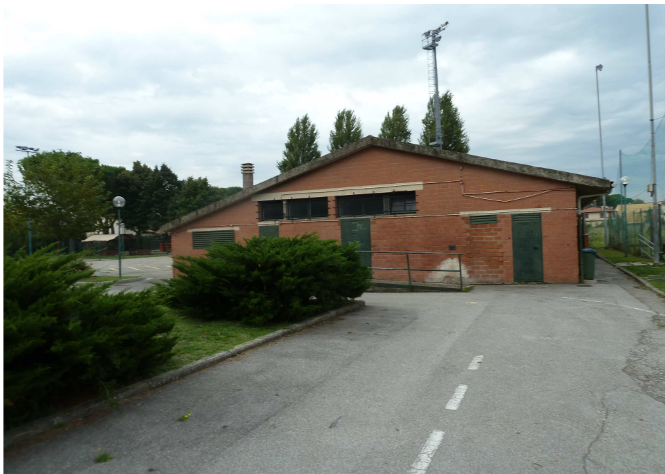
edificio spogliatoi e servizi igienici
