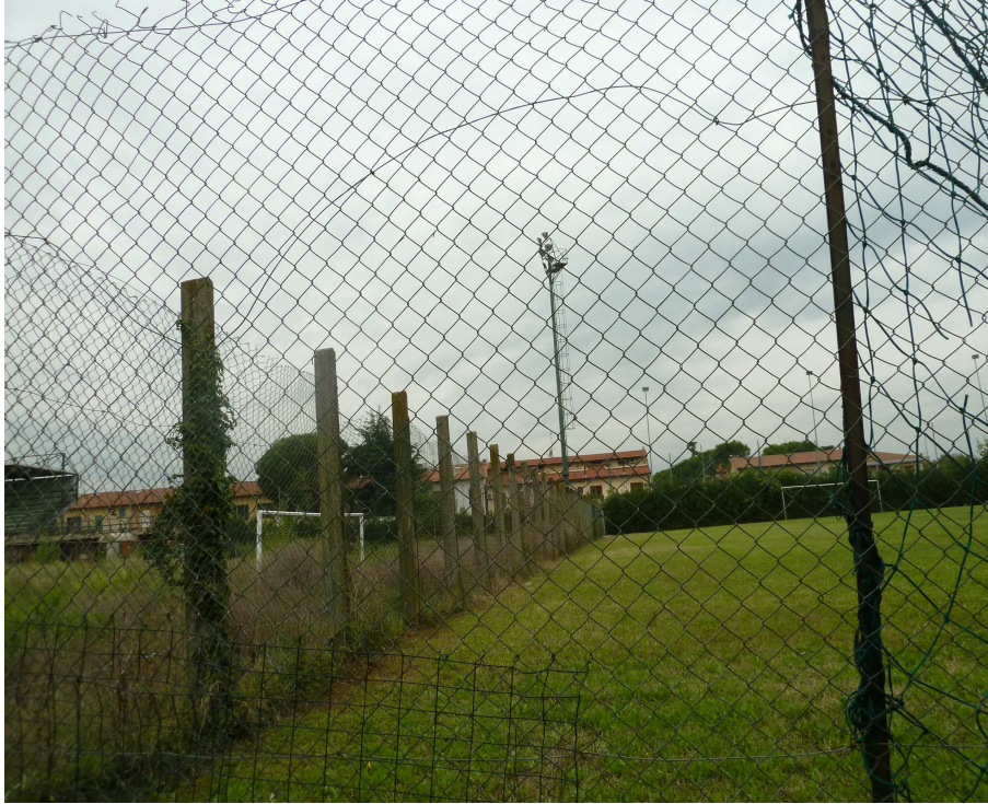
rete metallica a maglia sciolta plastificata con pali di sostegno in cls armato
