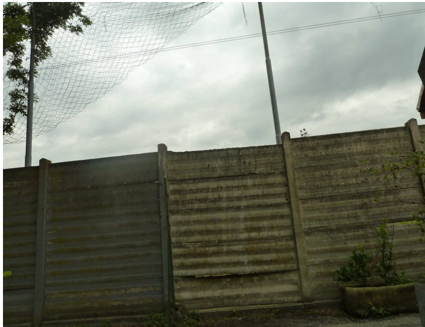
pannelli prefabbricati in cls armato con pali di sostegno in cls armato
