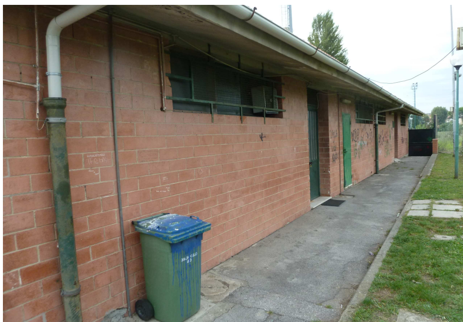
edificio spogliatoi e servizi igienici
