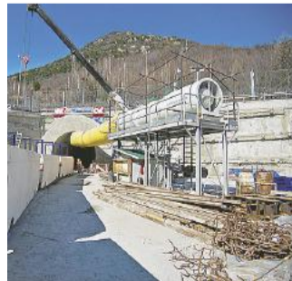
Un cantiere Tav LaPresse
